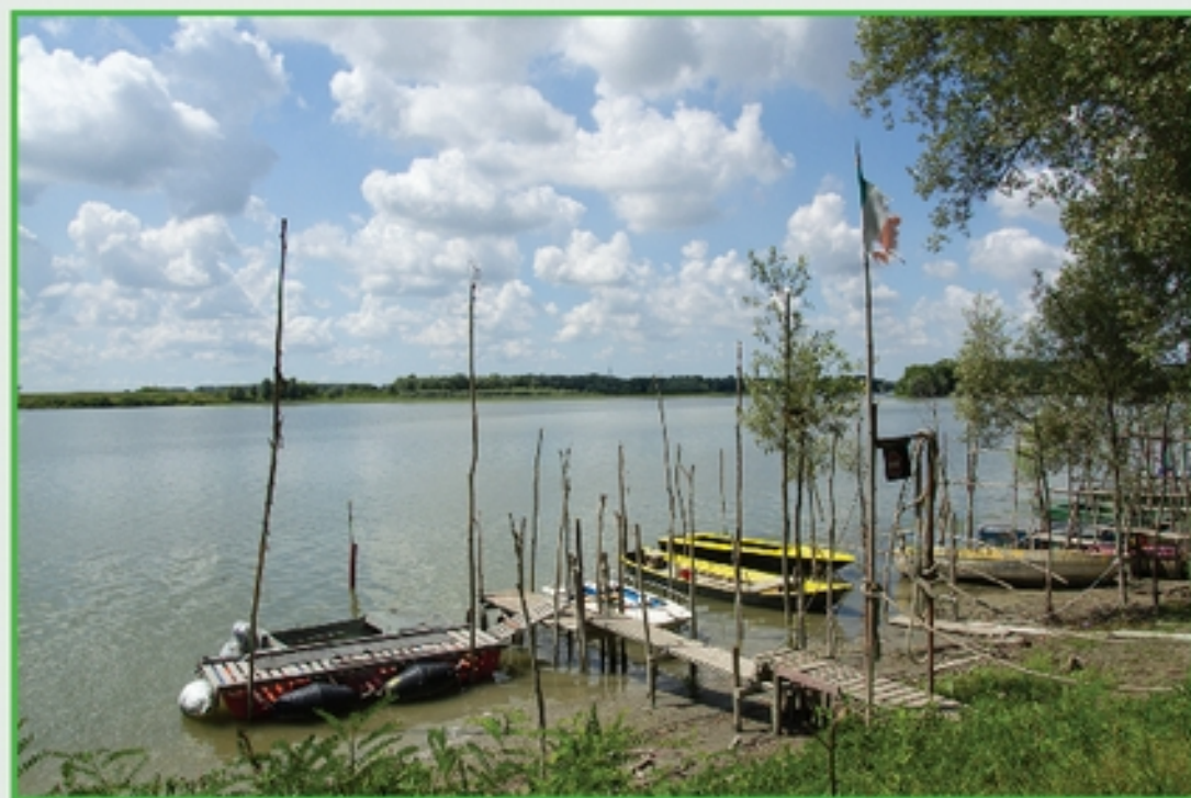
ADRIA Argine sinistro fiume Po di Venezia
